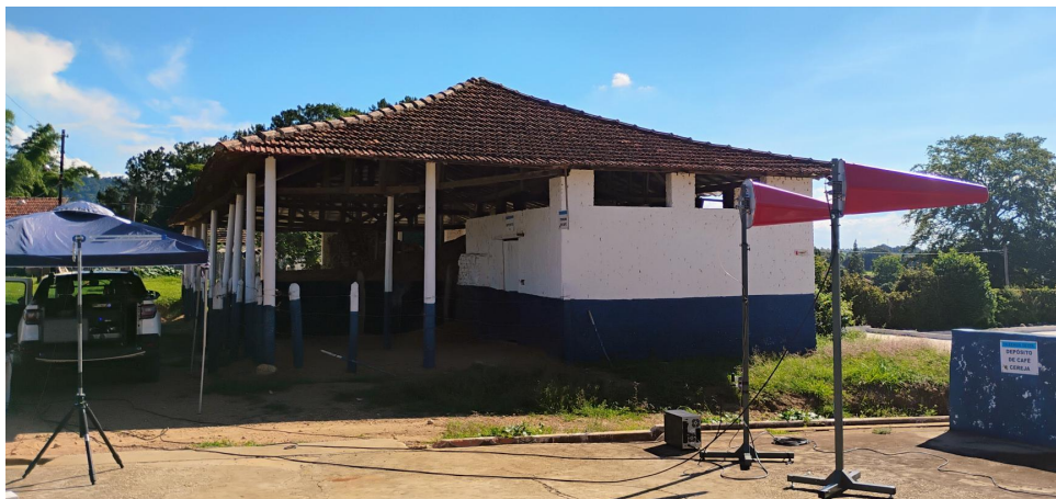
Figura 10: Visão geral da instalação na fazenda.
