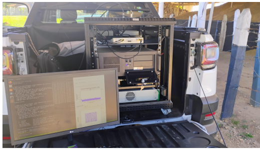
(a) Instalação do UE 2.
