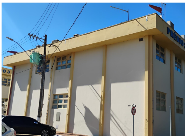
(b) Instalação das antenas do UE.
