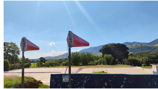
(b) Instalação das antenas do UE 2.
