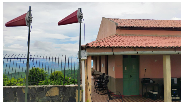
(b) Vista externa da instalação do UE 1.
