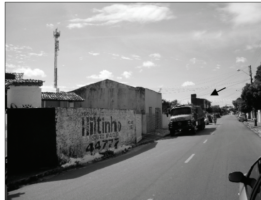
Fig.3. Região de cobertura da BTS Alberto de Brito. A seta representa a edificação como área de sombra.
